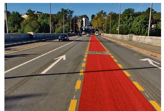
In Bern, hier auf der Lorrainebrücke, gibt es breitere Velostreifen und weniger Platz für Autos.
